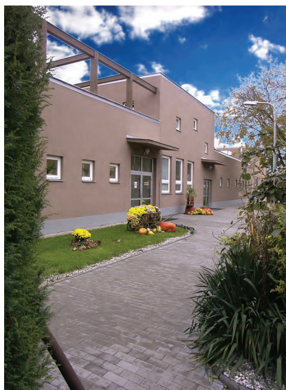
Budova nové haly
